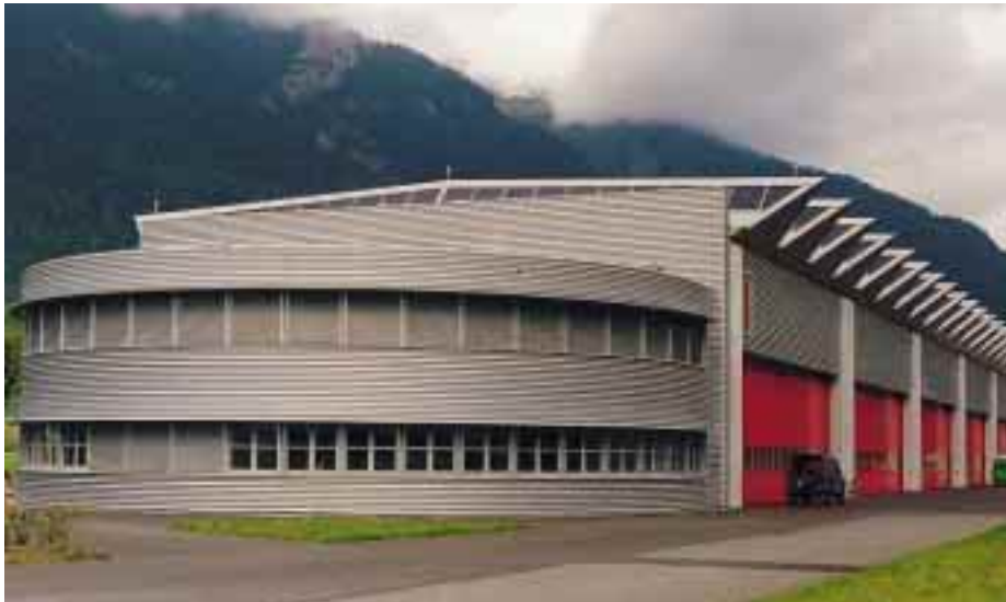
Jedes der 20 Sheds ist auf der Nordseite mit Oberlichtern und auf der Südseite mit 22 Solarmodulen bestückt
