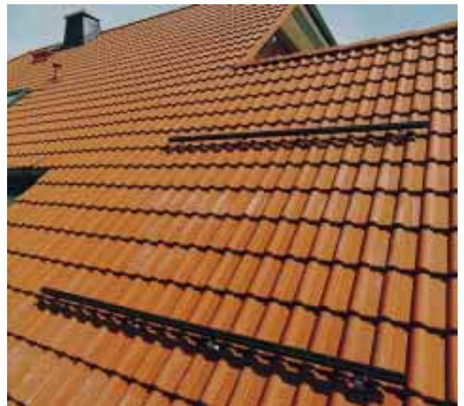
Bild 5 Sind die Montageschienen befestigt, kann auch das Dach geschlossen werden
