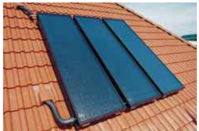
Bild 12 Die Montage ist abgeschlossen
