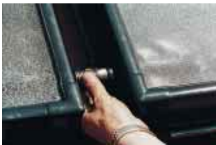
Bild 8 Ein flexibles Stecksystem sorgt für einfache Verbindung der Kollektoren untereinander
