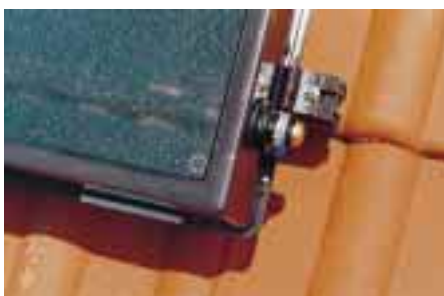
Bild 9 Die seitlichen Anschlüsse werden mit Stopfen verschlossen
