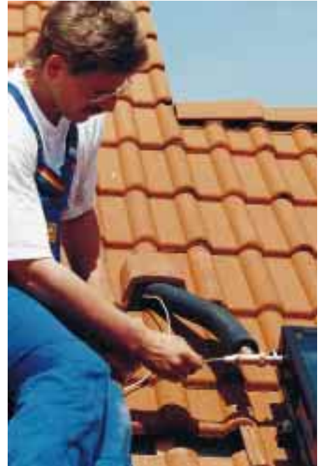
Bild 11 Der Temperatursensor der Solarregelung wird durch eine Tauchhülse eingeführt
