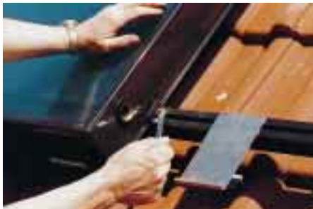
Bild 7 Klemmsteine sichern den Kollektor selbst gegen Sturmböen
