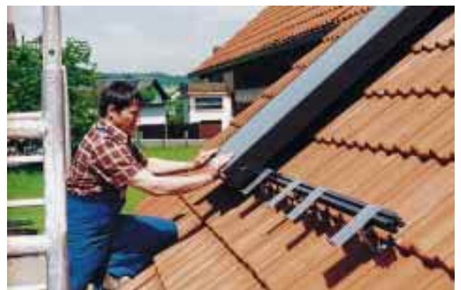
Bild 6 Montagebleche halten den Kollektor, wenn er aufs Dach gebracht wird
