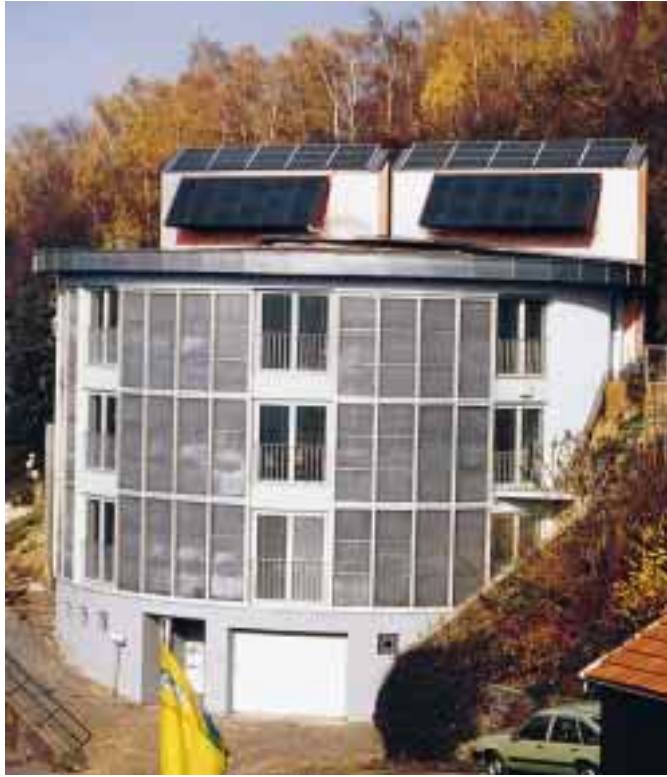
Prämiertes, solares Niedrigenergiehaus bei Pforzheim mit transparenter Wärmedämmung, Sonnenkollektoren und Photovoltaikanlage
