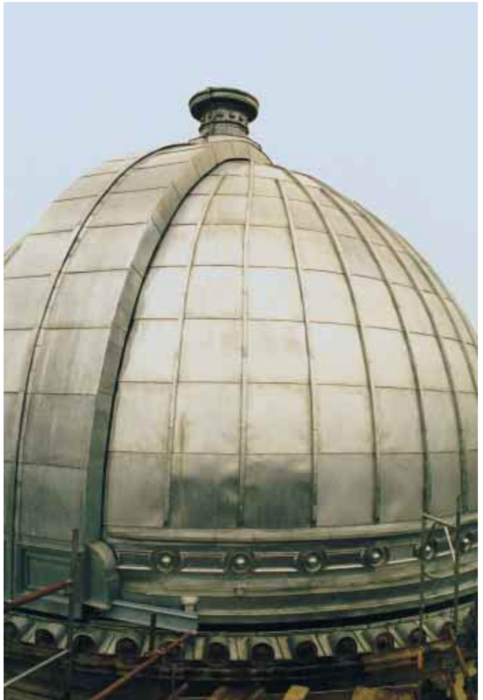
Die Abdeckungen der um 360° drehbaren Kuppel und der zweiteiligen Kuppelspaltabdeckung des Straßburger Observatoriums mußten nach über 115 Jahren erneuert werden [1]
