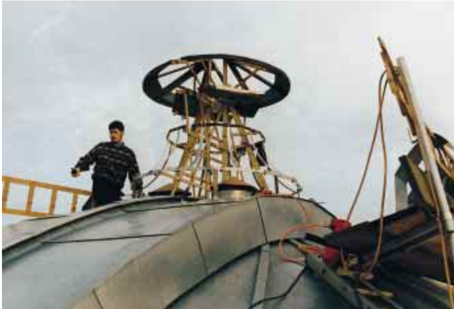
Unterkonstruktion der Krone mit den Entlüftungshauben des Observatoriums [1]
