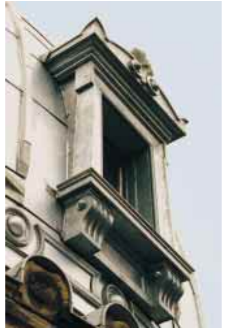
An jeder Seite der Kuppelhälften ist ein aus Blech hergestelltes Mansardenfenster angeordnet [1]
