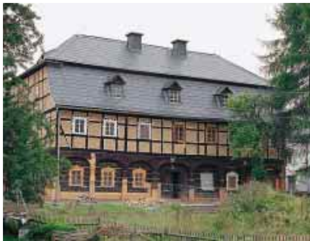
Die „Alte Mangel“ im sächsischen Ebersbach ist das Modellobjekt des ZHD für die denkmalgerechte Ausstattung von Umgebendehäusern mit haustechnischen Anlagen
