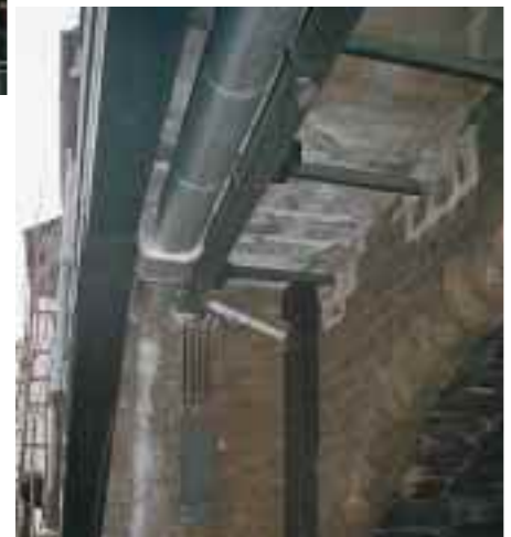
Die Fachwerkgebäude auf der Krämerbrücke in Erfurt erhielten eine mit Fernwärme betriebene Heizung. Mit dem Verlegen der Ringleitung unter der Brücke gelangen platzsparende Hausanschlüsse (Ing.-Büro Hirsch, Erfurt)
