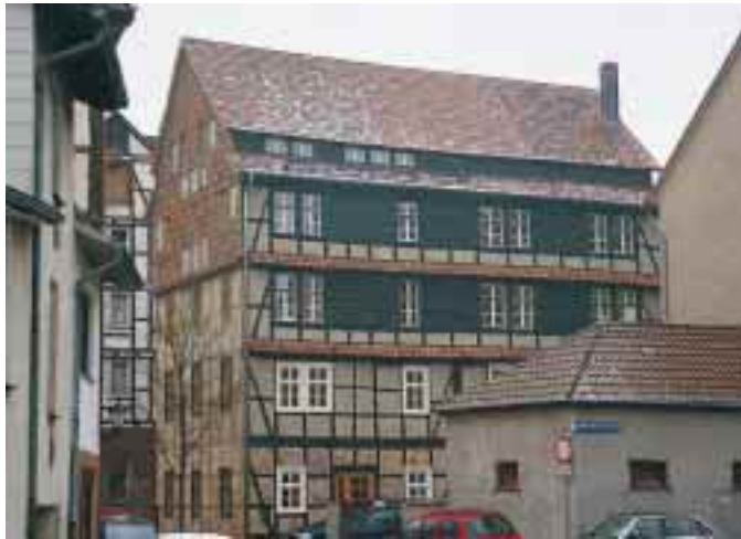
Das Lohgerberhaus in Eschwege wurde mit einem Temperiersystem ausgestattet
