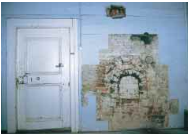
Wertvolle Hinweise für die Hausgeschichte liefert diese freigelegte alte Feuerung (ZHD, Eckermann)
