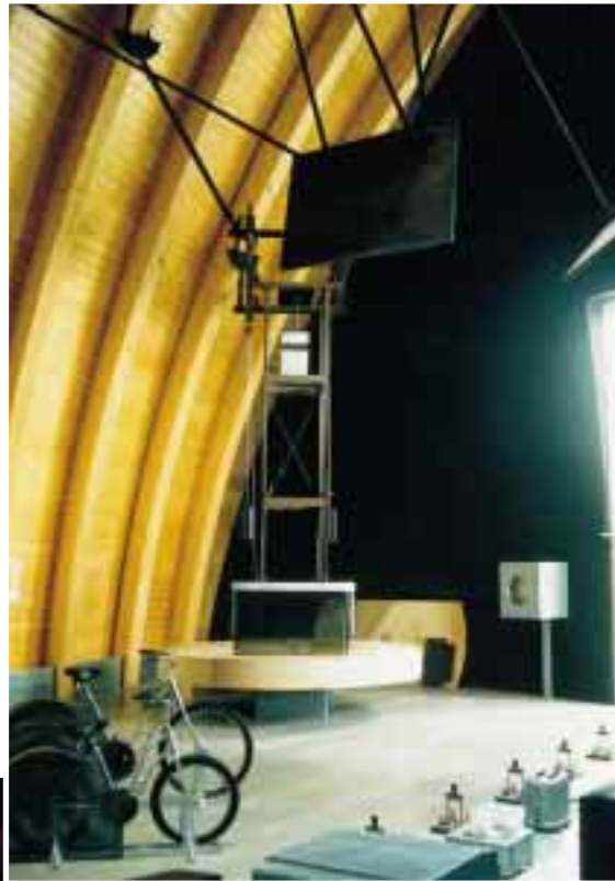
Bild 28 . . . und dann in der fertig ausgebauten Phase
