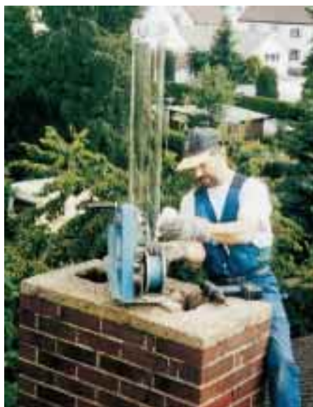
Roland Kluger bei der Montage einer Querschnittsverminderung
