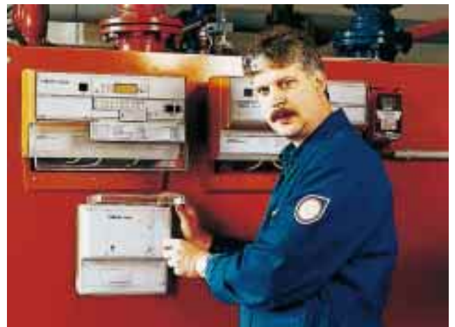
Bild 2 Das Gateway „Dekatel“ gewährleistet die universelle Anbindung des „Dekamatik“-Systems an die Außenwelt, wie Fernwirken und -überwachen, GLT oder EIB. Auch bestehende Anlagen lassen sich nachrüsten
