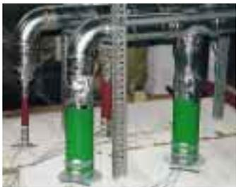
Wavin Tigris oder Fusiotherm Stabi konnten bauaufsichtliche Zulassungen für die brandschutztechnische Sicherung erlangt werden.
