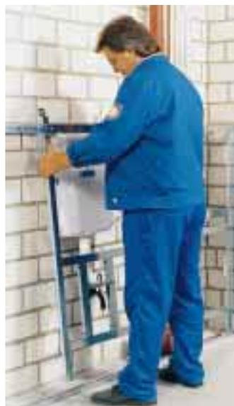
Für die Montage im Schienensystem wurde umfangreiches Systemzubehör entwickelt. Die Waschtisch-, Urinal-, Bidet-, Dusch- und Wannenelemente können jetzt auf bauliche Vorgaben angepaßt werden. Durch den neuentwickelten Schnellverschluß wird die Montagezeit verringert. Für weitere Informationen steht eine 52seitige Broschüre zur Verfügung.
