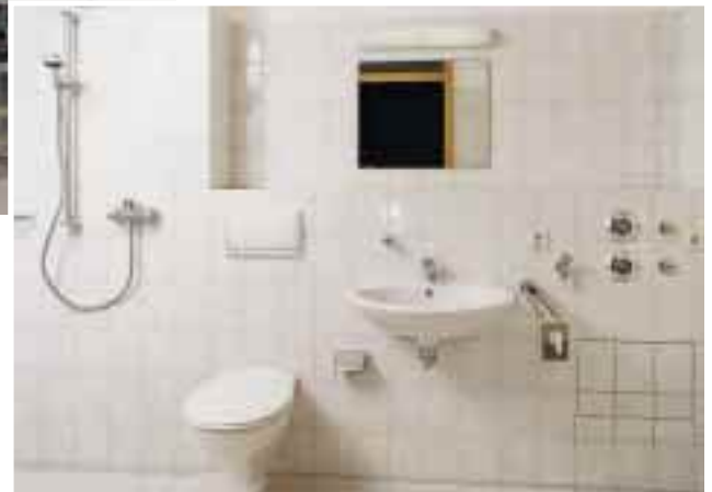
Die Ausstattung der Sanitärräume berücksichtigt die mitunter eingeschränkte Mobilität der Bewohner, so daß auch Rollstuhlfahrern die nahezu uneingeschränkte Nutzung möglich ist
