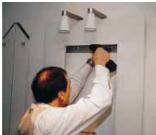
4. Oberen Winkel befestigen, Grundplatte senkrecht ausrichten
