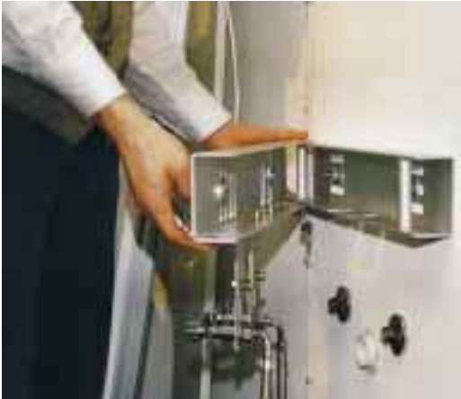
1. Befestigung der Wandtraverse an den alten Waschtischbefestigungen und Aufsetzen der Fronttraverse
