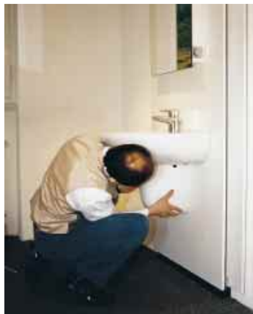
6. Waschtisch, Siphon und Halbsäule montieren, Accessoires an Funktionschiene klemmen und fertig. Das ganze dauert ca. 2 h
