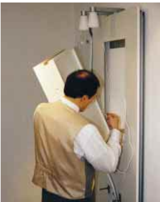
5. Stromanschluß an Spiegelschrank herstellen; Spiegelschrank einsetzen, anschließend noch den äußeren Sockel anbringen
