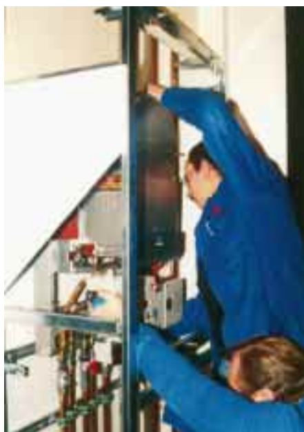
Im Rahmen GGS-Veranstaltung wurde der Ein- und Ausbau einer Gastherme im VWI-Schachtmodul vorgeführt
