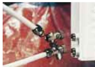
Garnituren für Einrohr- und Zweirohrsysteme, die es in verschiedenen Varianten gibt, nun alle 60 mm lang und im fertig installierten System untereinander austauschbar. Und schließlich sind die Kugelhahnblöcke für Einrohrsysteme auch in Zweirohrsystemen verwendbar. Außerdem wurde das Programm durch eine Eckvariante zu allen Versionen vervollständigt.
