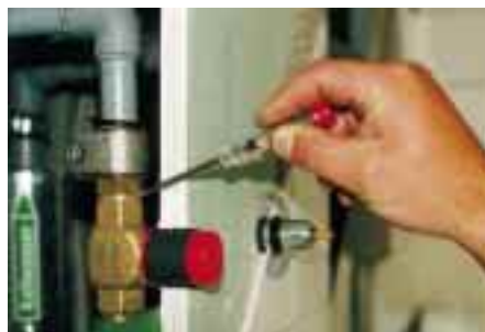
Die Spitze des Schraubenziehers zeigt eine montierte vorbeschichtete Gewindeverbindung
