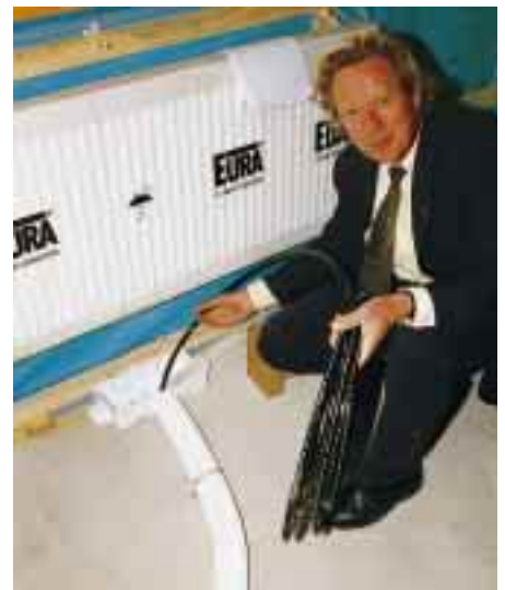
Göran Bernhardsson, der das Pluggit-System entwickelte, zeigt, wie die Kanäle bei Bedarf gereinigt werden können
