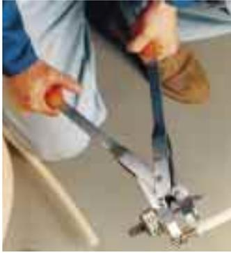
wurde eine Handzange zum Aufschieben der Druckhülsen entwickelt. Sie ist für Arbeiten geringeren Umfanges gedacht, besonders auch bei schwer zugänglichen Leitungsabschnitten.
