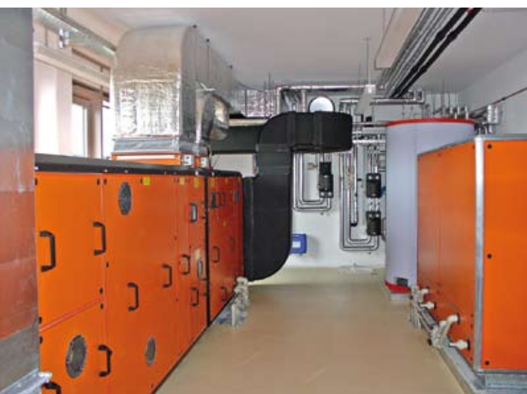
Neuartiges Klimagerät von Menerga mit einem Absorptionsprozess zur Entfeuchtung der Luft
