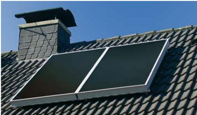
**Kernelement der neuen Solaranlagen bei Rapido ist der Flachkollektor Rapidosolar FK 26**
