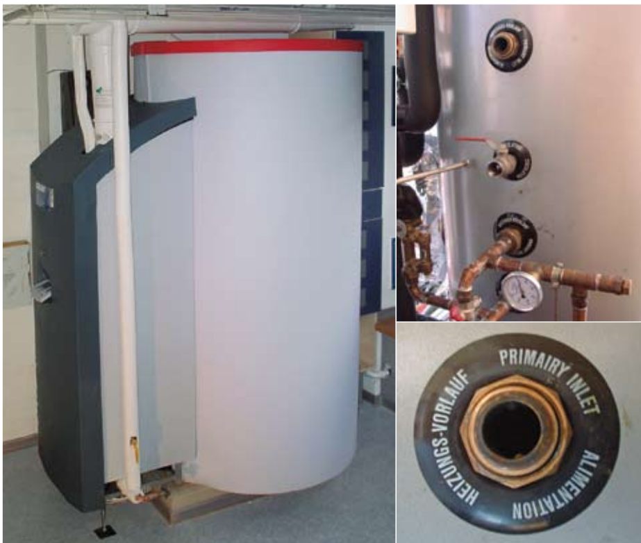
Bild 2 Kompakte solare Kombianlage der Firma Solvis (l.) und Energiespeicher der Firma Austria Email mit bereits angebrachter Wärmedämmung (o.) und genau gekennzeichneten Anschlüssen (u.)
