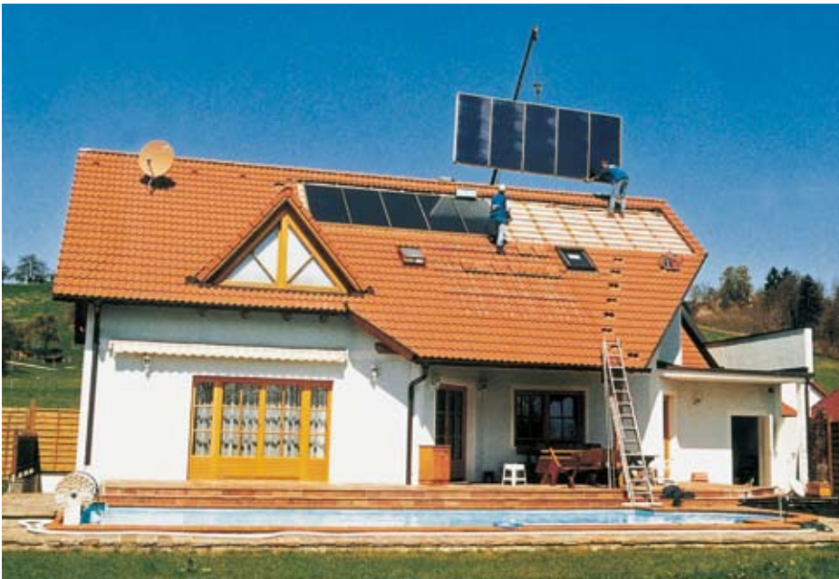
Bild 3 Dachmontage eines großen Kollektorfeldes mit Hilfe eines Krans
