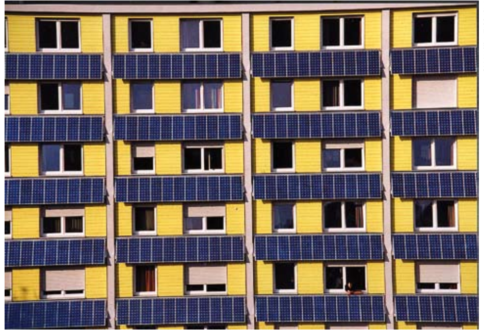
PV-Module in der Fassade eines Lehrlingswohnheims in Freiburg
