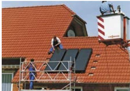
Kleinere thermische Solaranlagen werden meist direkt vom Installateur ausgelegt. Ein hoher Vorfertigungsgrad durch den Systemanbieter hilft, die Montage zu erleichtern und Fehlerquellen zu minimieren. Worauf dabei zu achten ist, erläutert Beitrag ab Seite
