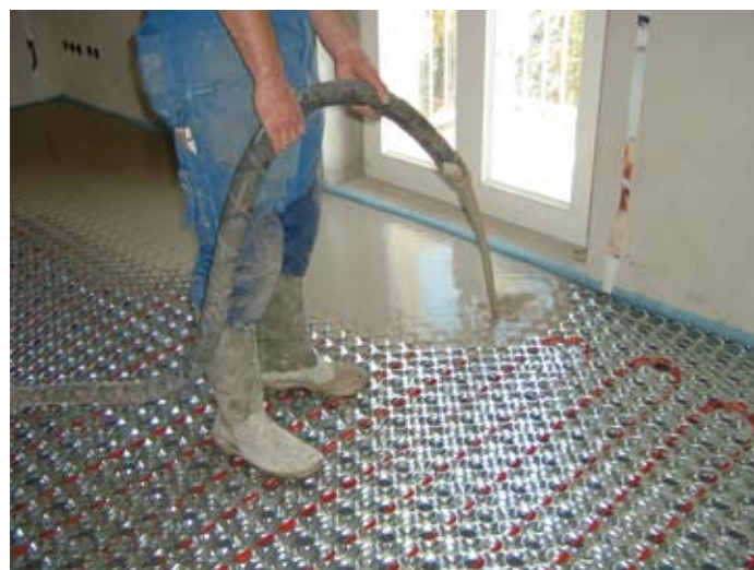
Estrichverguss beim flachen, wabenförmigen Fußbodenheizsystem Effidur (für Verkehrslasten bis zu 500 kg/m 2 )
