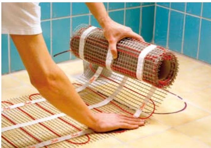
Danfoss bietet zwei Elektro-Fußbodentemperierungssysteme an: die Systemplatten EFCI Dry (o.) und die flachen EFTI-Heizmattensets
