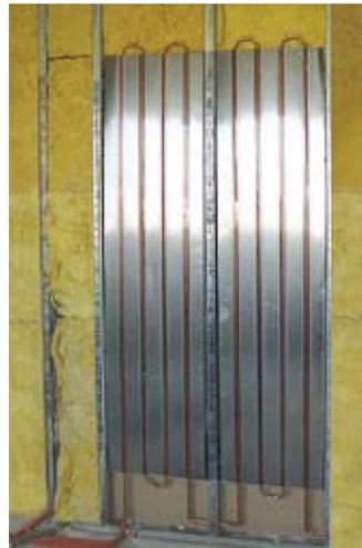
Bei der Ständerwandmontage wird der Unterwand-Heizkörper von Kälberer mit einem ausziehbaren Haltersatz befestigt
