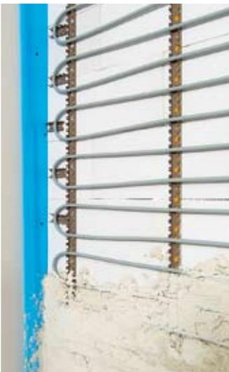
Die Prineto-Fixschiene für die Anwendung am Boden dient nun auch als Wandheizungssystem für verputzte Wände
