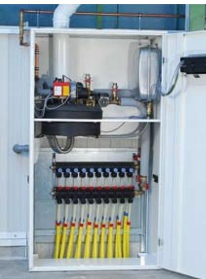
Die anschlussfertige Heizzentrale GasHeizUnit GHU ist in einem Fußbodenheizungs-Verteilerschrank vormontiert
