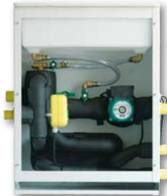
Kompaktes Wärmequellenmodul zur passiven Kühlung von Waterkotte
