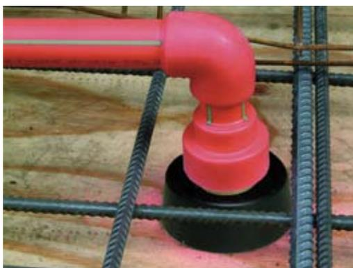
Mit Firestop bietet Aquatherm ein aus Rohren und Verbindungselementen bestehendes System zur Erstellung von Feuersprinkleranlagen an
