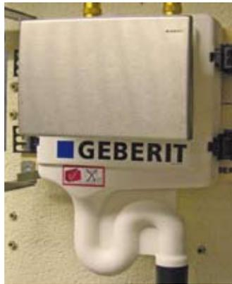
Mit der neuen Hygienespülung wird laut Geberit der Austausch des stagnierenden Trinkwassers gewährleistet
