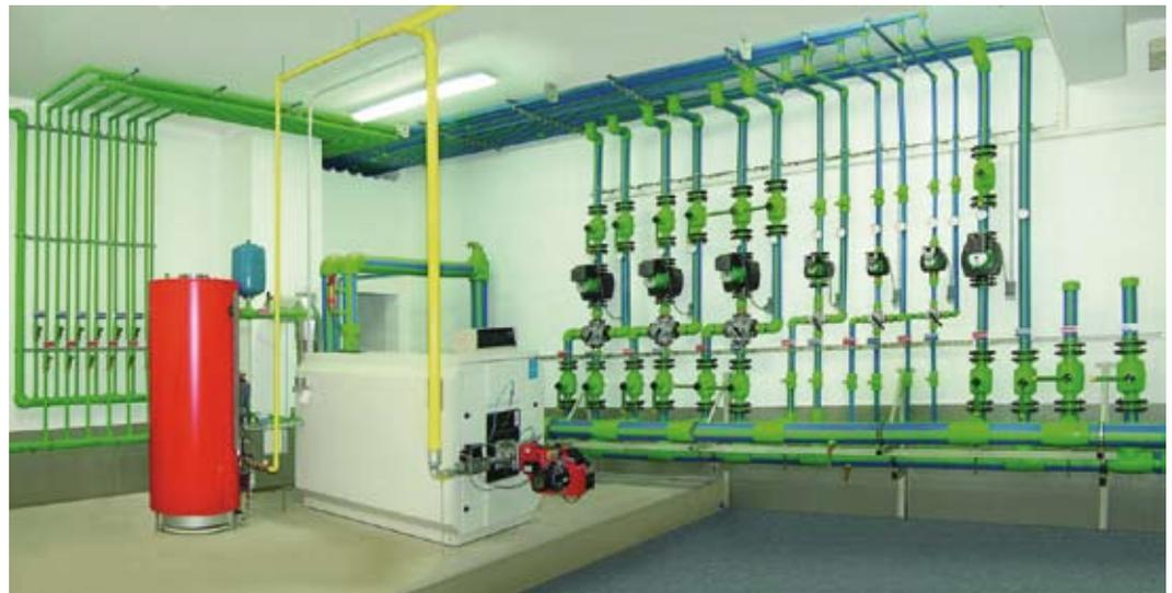
Aquatherm plant und baut neuerdings auch Verteiler nach Maß
