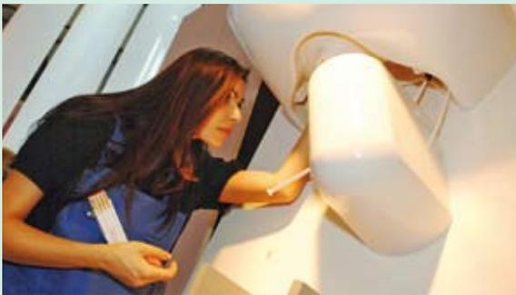
Villeroy & Boch präsentierte ein neues, die Montage vereinfachendes System für Halbsäulen, bei dem die Befestigung mit einer Art Kabelbinder erfolgt
