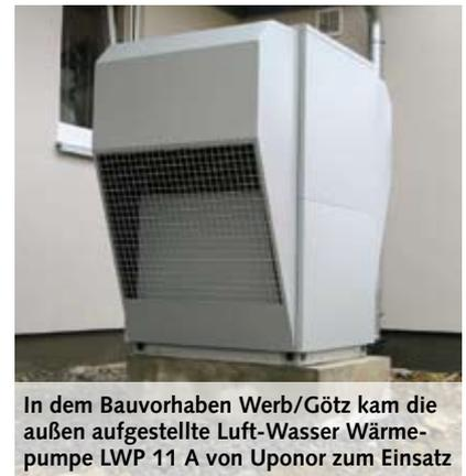
In dem Bauvorhaben Werb/Götz kam die außen aufgestellte Luft-Wasser Wärmepumpe LWP 11 A von Uponor zum Einsatz
