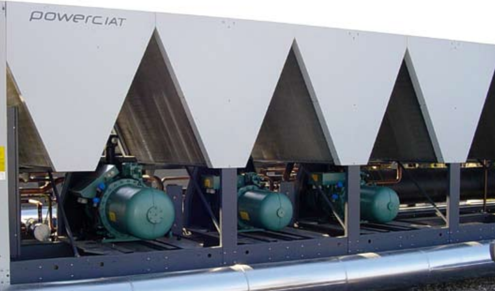
Das Herz eines Kaltwassererzeugers ist der Verdichter. Er übt einen großen Einfluss auf die Leistungszahl aus. Das Bild zeigt einen Kaltwassererzeuger mit drei Verdichtern (grüne Lackierung) und darüber vier Verflüssigern (V-Form)
