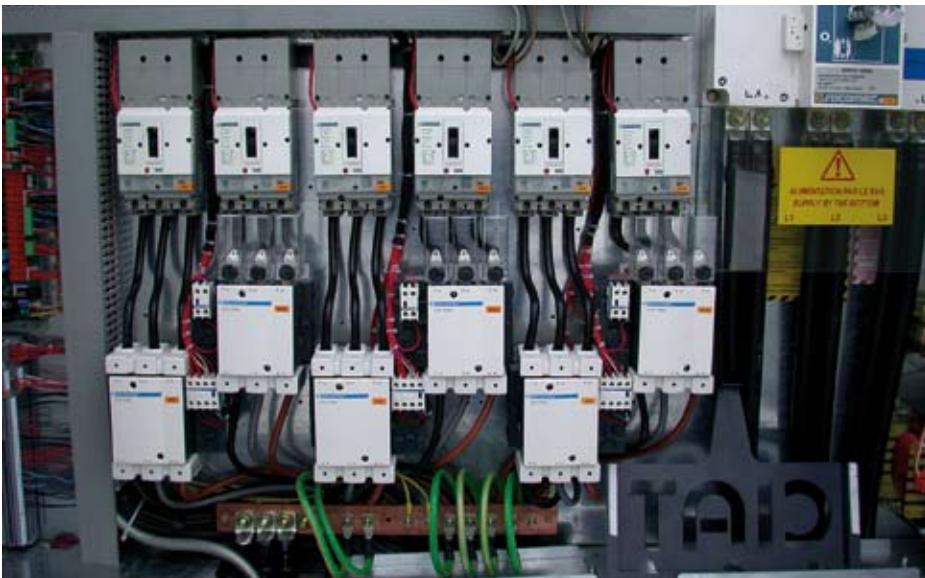
Kaltwassererzeuger werden komplett vormontiert mit Schaltschrank und allen erforderlichen Verdrahtungen hergestellt
