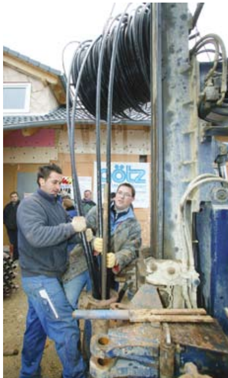
Bild 3 Bohrung und Installation einer Erdsonde für eine Wärmepumpenanlage
