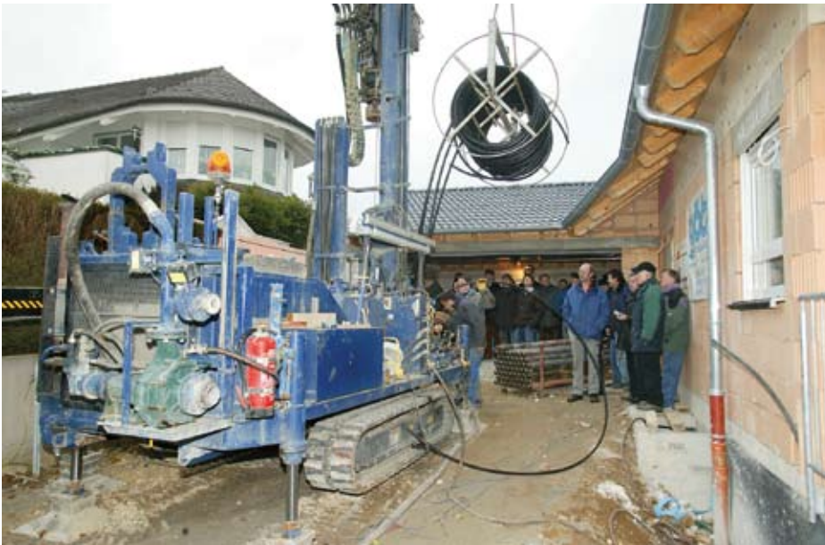
Bild 6 Bei einer „Erdsondenparty“ können Interessenten die Bohrung live miterleben.
