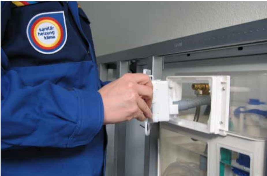
Bevor die Beplankung des Spülkastens mit Gipsfaserplatten erfolgt, wird er noch wasserseitig angeschlossen und für die spätere Montage der Betätigungsplatte vorbereitet
