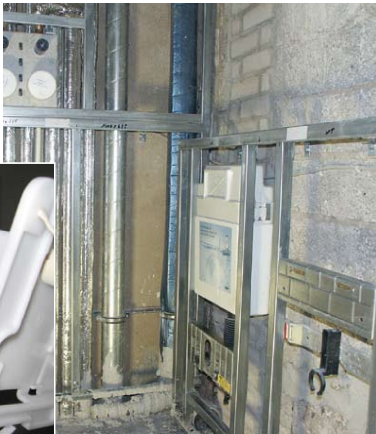
Werksseitig vorgefertigt: Installationsschacht, Step-WC-Element mit UP-Spülkasten Sanicontrol R 11 und Waschtisch-Element
