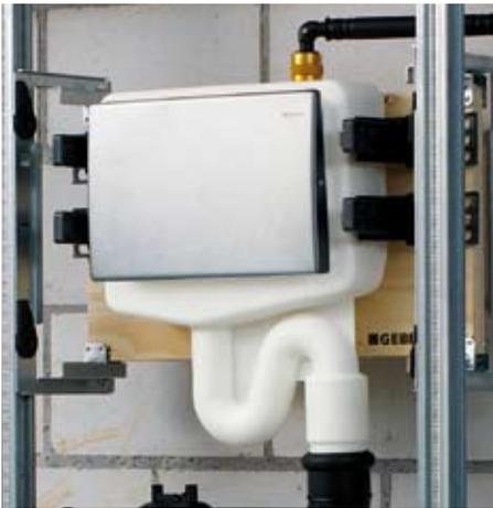
**Bild 4** Produkte mit automatischer Hygienespülung verhindern lange Stagnationszeiten des Trinkwassers
