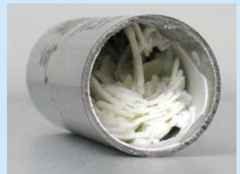
Bild 8 Infarktartiger Rohrverschluss in einem Edelstahlrohr, verursacht durch abgeplatzte Beläge, die anschließend verkleben
