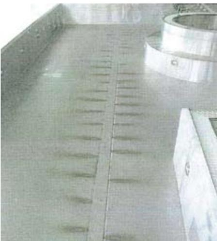
**Bild 16** Verfärbungen an Hallenbadboden aus nichtrostendem Stahl, verursacht durch eingeschleppten Rost aus Netz-/Befüllungsleitungen (Umgehung des Feinfilters)
