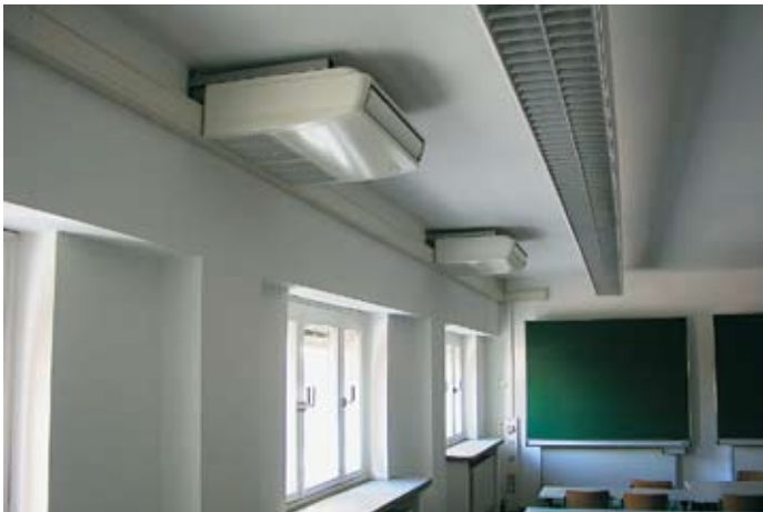
Bild 4 Einsatz von Unterdeckengeräten in einem Seminarraum (links die falsche und rechts die richtige Anordnung)
