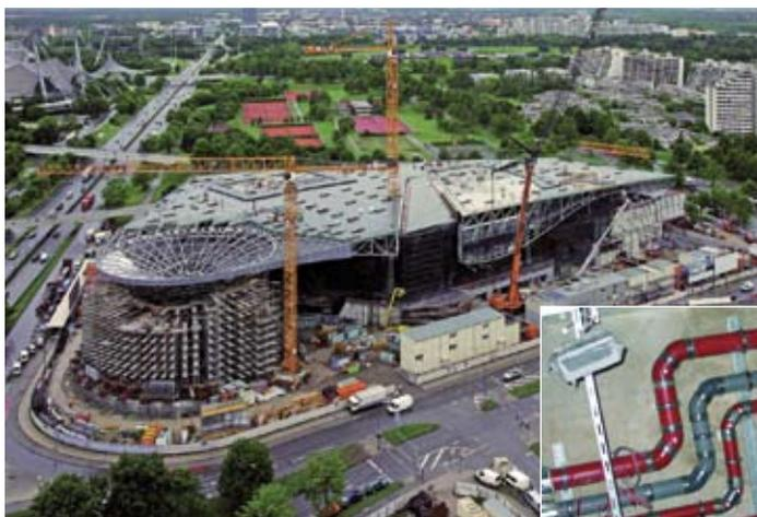
In der neuen BMW-Welt werden 16 500 m<sup>2</sup> Dachfläche über 52 EPAMS HDE UNO-Abläufe entwässert
