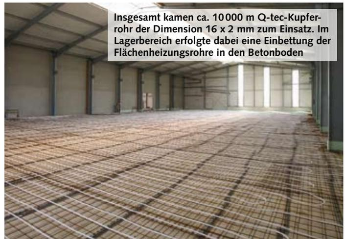
Insgesamt kamen ca. 10000 m Q-tec-Kupferrohr der Dimension 16 x 2 mm zum Einsatz. Im Lagerbereich erfolgte dabei eine Einbettung der Flächenheizungsrohre in den Betonboden
