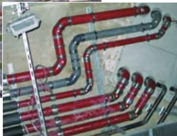
SML und KML-Rohre werden unterhalb der Tiefgaragendecke in den Schmutzwasserkanal geführt
