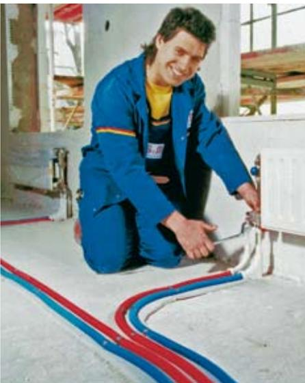
Heizkörperanbindung mit bereits vorge-dämmten Kunststoffrohren
