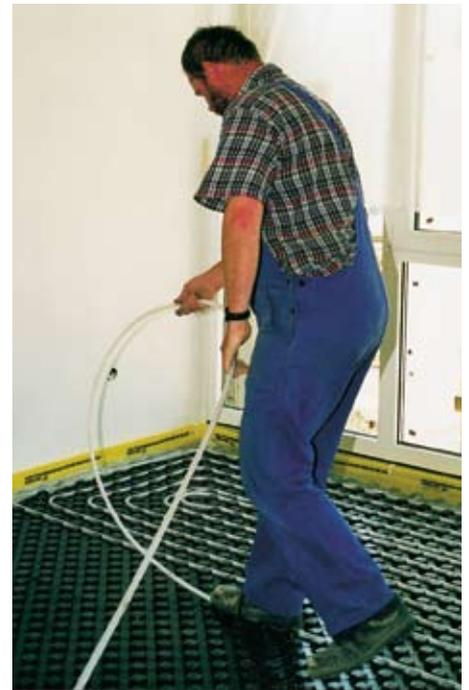
Rohrverlegung für eine Warmwasserfußbodenheizung
