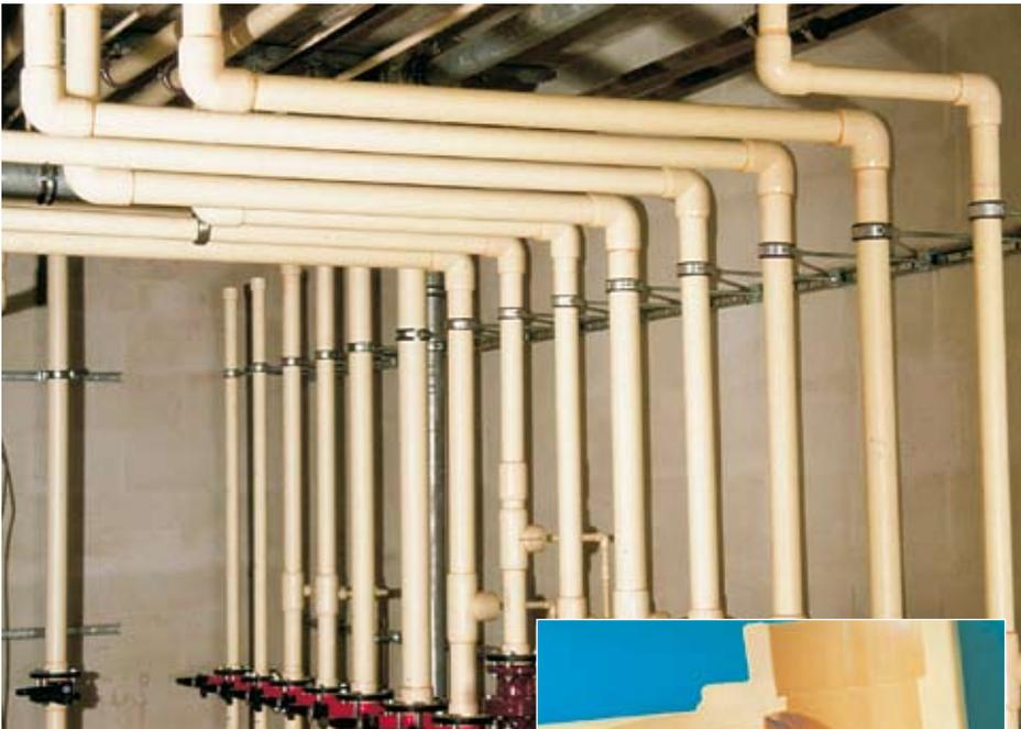
Die Kellerinstallation wurde mit Rohren und Fittings aus PVC-C durchgeführt
