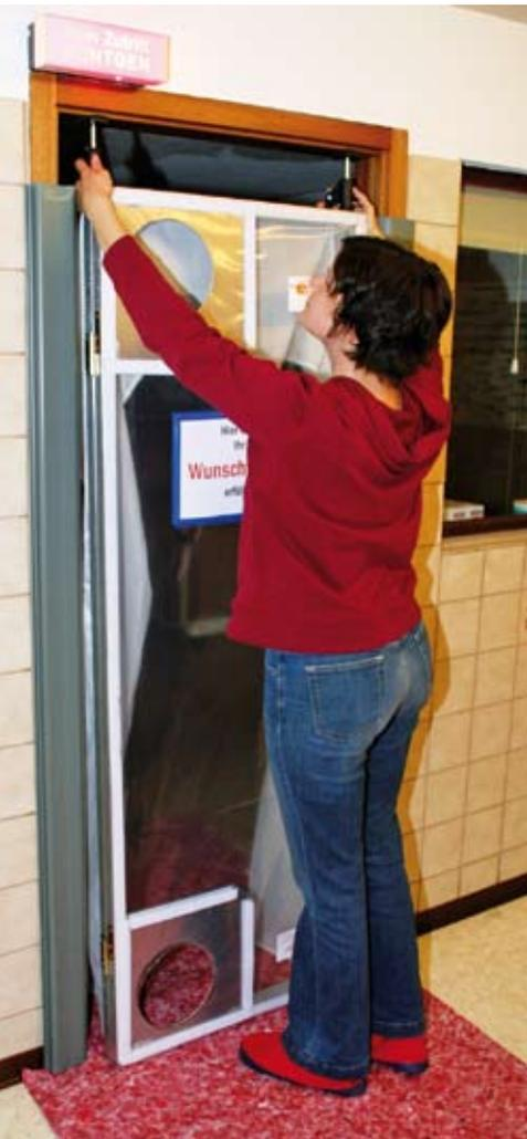
Komplette Schwingtüre in den Türrahmen einsetzen und mittels der integrierten Teleskopstangen festklemmen...
