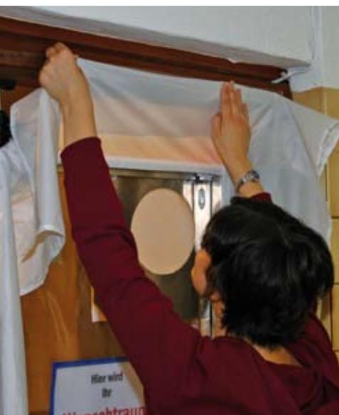
...Danach wird die Schwingtüre mit doppelseitigem Klebeband abgedichtet
