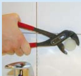
Zur Demontage Pad mit der Zange fassen und abdrehen
