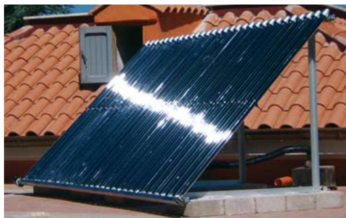
Bild 5 Mit einer Kollektorbreite von nur je 62,5 cm können die Module bei einer geringen freien Dachfläche flexibel eingesetzt werden (hier eine aufgeständerte Lösung)
