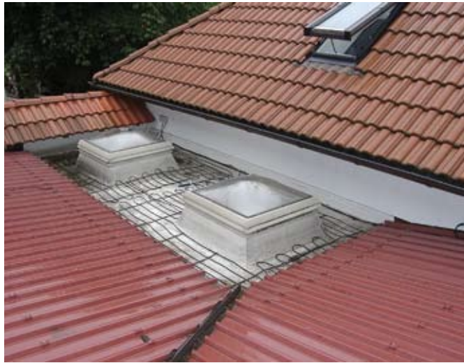
Mit Hilfe der Heizkabel wird in Zukunft das Freischaufeln des Flachdachs der Vergangenheit angehören
