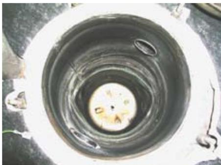
**Glattrohr-Wärmetauscher in Verbindung mit schwefelarmem Heizöl sorgen für den für geringsten Wartungsaufwand. Hier die Brennkammer des „Icovit“ nach einem Jahr Praxisbetrieb. Zur Reinigung reicht ein Tuch**
