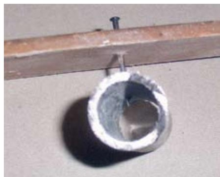
**Ist die Gasleitung nach der Erstellung drucklos, kann alles Mögliche mit ihr passieren – die Ausführung einer zweiten Hauptprüfung ist also sinnvoll**
