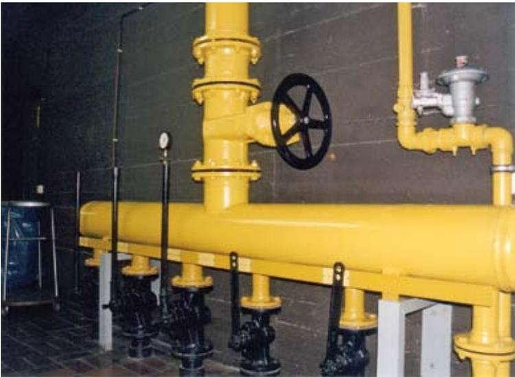
**Großvolumige Leitungen erfordern bei der Hauptprüfung mehrstündige Prüfzeiten**
