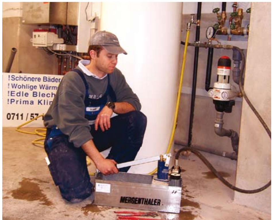
**Bild 1:** Der vom Pressfittingshersteller empfohlene Prüfdruck darf beim Füllen des Leitungssystems nicht überschritten werden
