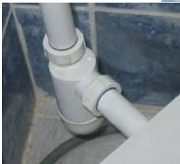
Kreativ: Zur Abwechslung kann man den Siphon doch auch mal ins Spülrohr einbauen, oder?
