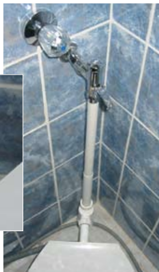
Kreativ: Zur Abwechslung kann man den Siphon doch auch mal ins Spülrohr einbauen, oder?
