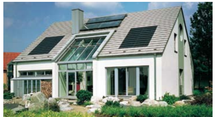
Solarthermie und Photovoltaik sind bei diesem Beispiel fachgerecht in optisch ansprechender Form auf dem Dach platziert
