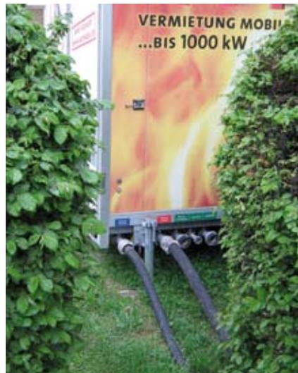
Unauffällig durch das Gebüsch verlaufen die flexiblen Verbindungsleitungen von der Mobilheizzentrale zum Heizraum des Gebäudes
