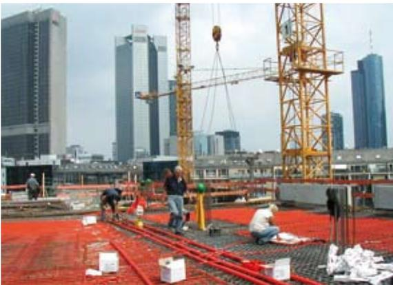
Rund 30 000 m PE-Xa-Rohre sind in die Betondecke integriert und werden später mit Kühlwasser durchströmt
