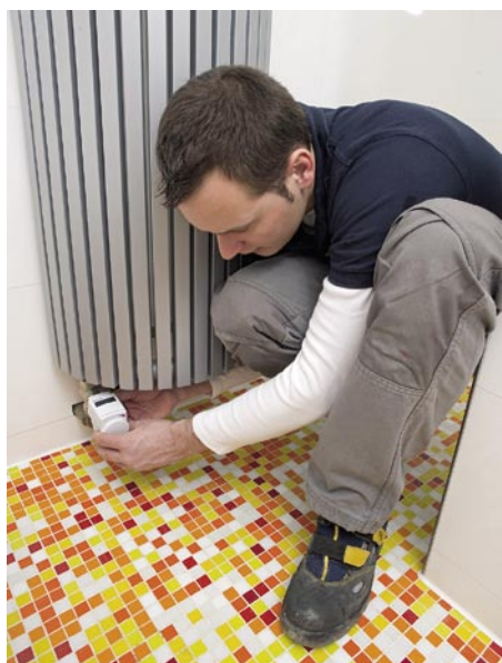
Bild 7 Bei der Installation wird das THV durch den Heizkörperregler HR80 ersetzt. Manchmal ist dazu noch ein Adapter erforderlich. Dann wird der Regler übergestülpt und mit der Hand festgezogen
