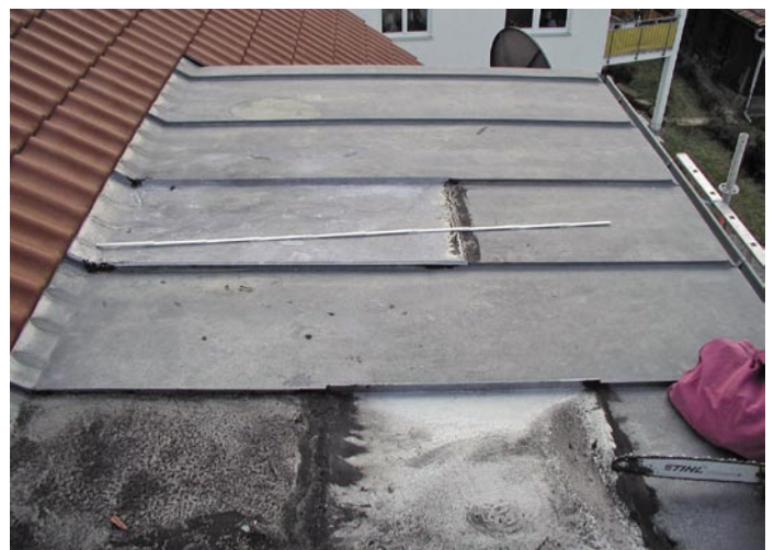
Vom Klempnerbetrieb wurden die Stehfalze der oberen Blechabdeckung zusätzlich abgeklebt
