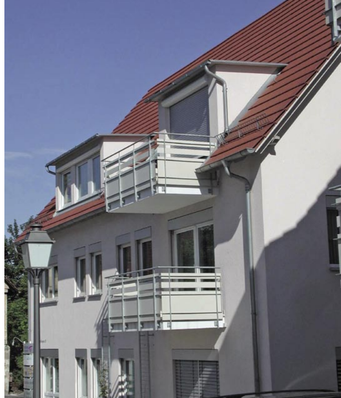
Die flach geneigten Gauben-Dächer des Gebäudes sind mit Titanzink verkleidet
