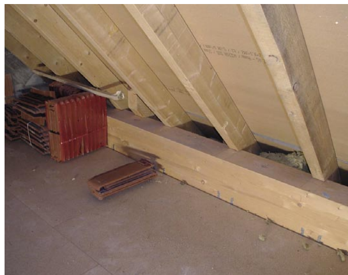
Blick vom Dachraum auf den oberen Anschluss der Gaube hinter der Mittelpfette
