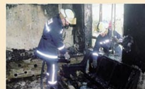
Nach 5 Minuten ist der Raum total ausgebrannt; Brandtote wären wahrscheinlich gewesen
