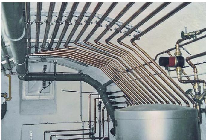
Die neu verlegten Heizungsrohrleitungen wurden den Rundungen des Gewölbes angepasst
